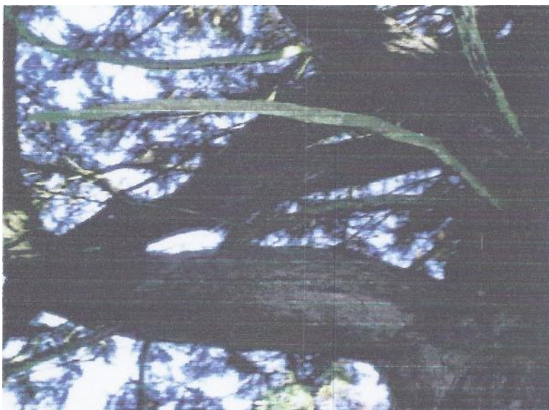
Erhöhte Bruchgefahr an schon verformten Starkästen
